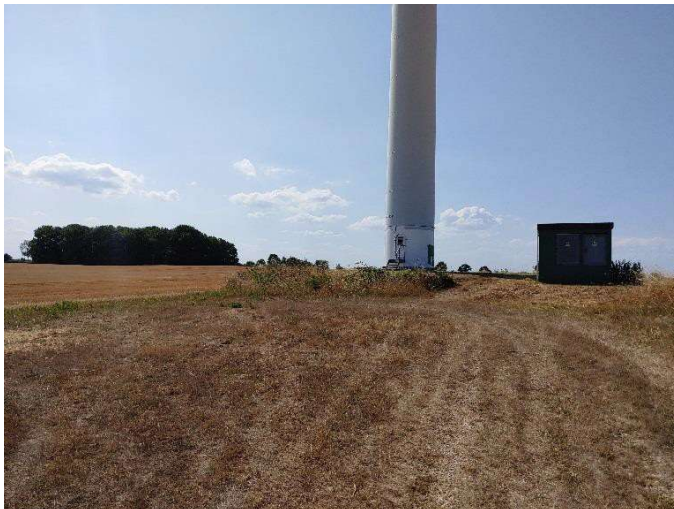
Ruderaler Staudenflur am Standort der Bestandsanlage WEA 4
