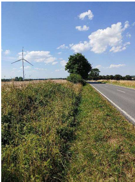
Graben mit unregelmäßiger Wasserführung entlang der K 47
