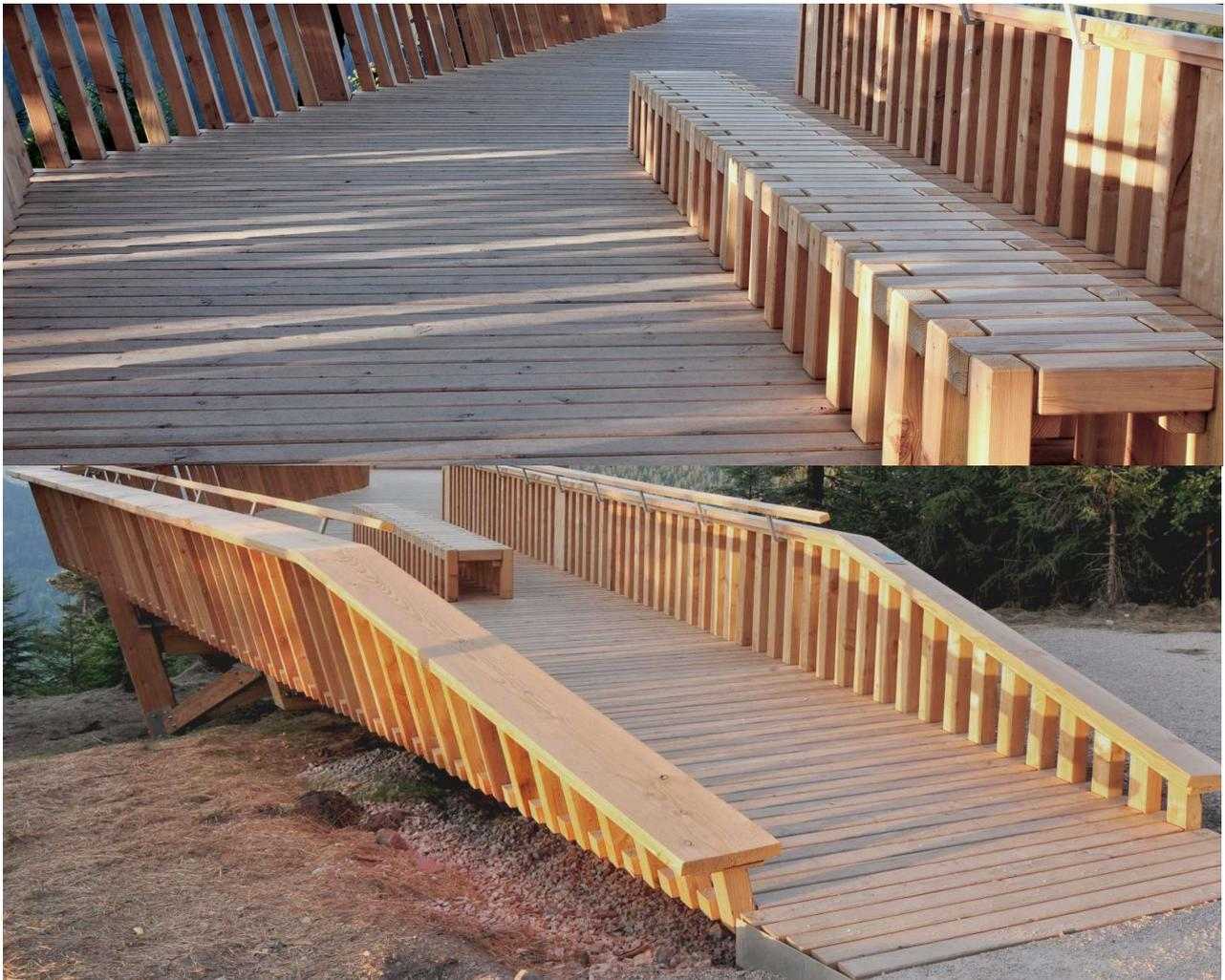
**Abb. 3 und 4:** Ausführungsbeispiel Ausbildung von Rampen – Herstellung erhöhter Ebenen
