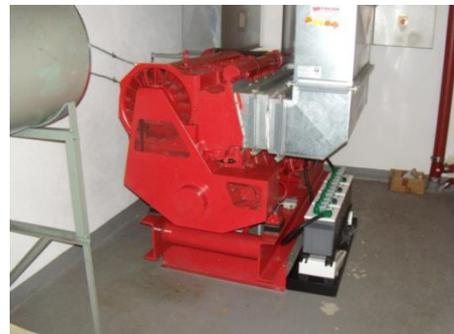
Abbildung 4 Die Netzersatzanlage (stationär) des Feuerwehrhauses in Korbach nach Quelle [4]
