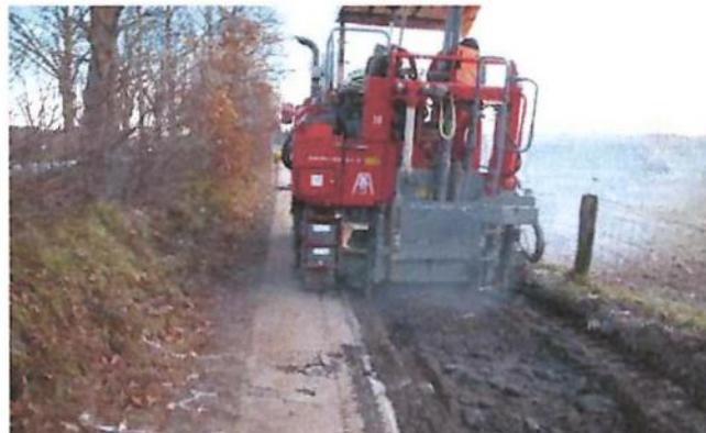
Aufräumen des Bestandsweges – Material wird weiterverwendet und als Tragschicht genutzt, so entstehen keine Fracht und entsorgungskosten sowie kein Notwendiger Rohstoffabbau. Im Baumbereich leichter Handaushub.
