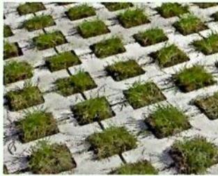
eine Pflasterung mit breiten Fugen.
