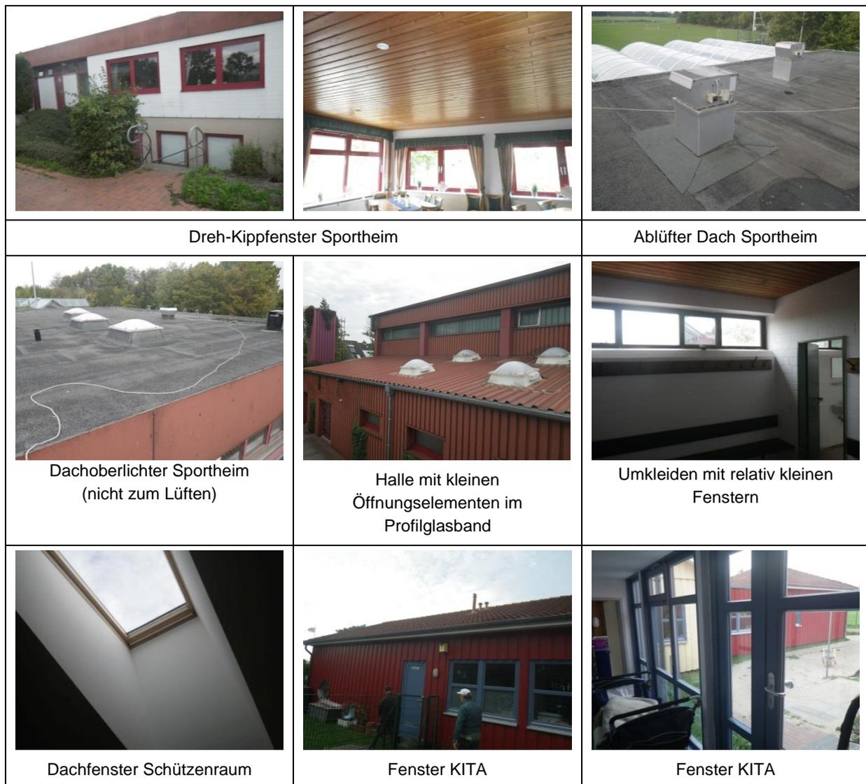
Abbildung 19: Übersicht Belüftungselemente
