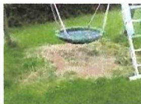
Unzureichende Ausdehnung der Aufprallfläche. Gem. DIN EN 1176-2:2017-12 Pkt. 4.10.2.1 wird die Ausdehnung der Aufprallfläche folgendermaßen berechnet: bei synthetischem Belag:  $0,867 \times \text{Länge der Abhängung} + 1,75 \text{ m}$  (+ 0,50 m hindernisfreier Raum) bei Naturböden und losem Schüttmaterial:  $0,867 \times \text{Länge der Abhängung} + 2,25 \text{ m}$ . Hier 4 m in beide Richtungen erforderlich.
