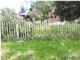
Zwischen den Spitzen des Zauns Fangstellen für Kopf und Hals: Teilweise umschlossenen und V-förmigen Öffnungen, deren Unterkante mehr als 600 mm über der Spielebene liegt, müssen so konstruiert sein, dass sie den Prüfungsvorgaben gem. DIN EN 1176-1:2017-12 Pkt. D.2.2 entsprechen. (z.B. Abstand zwischen Holzlatten und/oder Tiefe zwischen Lattenoberkante und Querholm an Zäunen geringer 45 mm).
