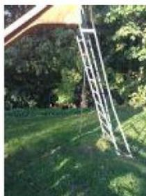
Brüstung (Seitenwange) zu niedrig. Rutscheneinstieg ist in der Fallhöhe über 200cm. Hier gelten die gleichen Anforderungen wie an Podeste. DIN EN 1176-3:2008-08, Pkt.4 ff Sicherheitstechnische Anforderungen. Achtung: Bestandsgeräte aus DIN EN 1176 DIN EN 1176-3, Pkt.4 ff Sicherheitstechnische Anforderungen
